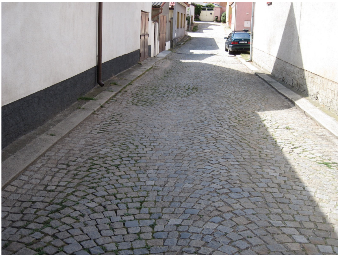
F02, km 0,031+ Deformace v dlážděném krytu vozovky
