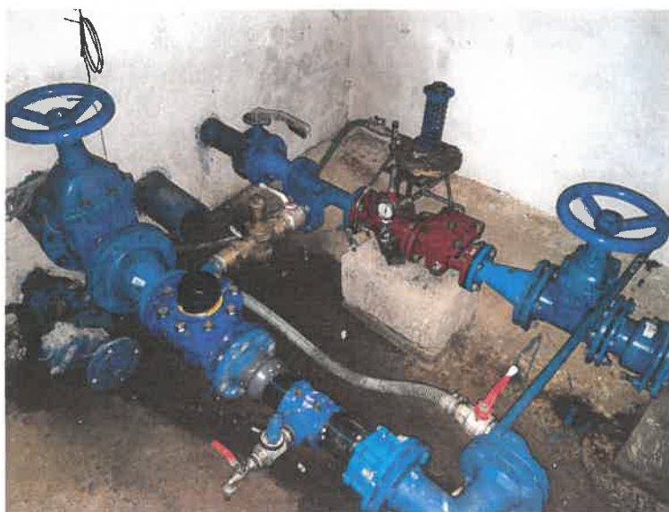
Obrázek 2 VDJ Cizkrajov – armaturní komora
