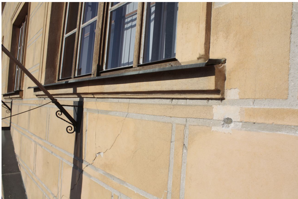
Obr. č. 17: stratigrafická sonda V3 pod oknem v patře
