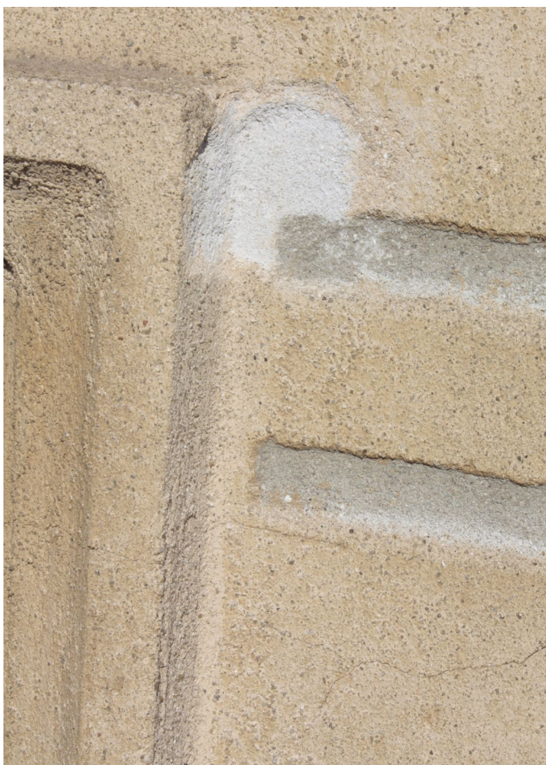
Obr. č. 54: stratigrafická sonda VJ3 u okna v patře
