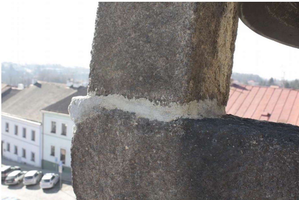
Obr. č. 30: detail spáry mezi kameny
