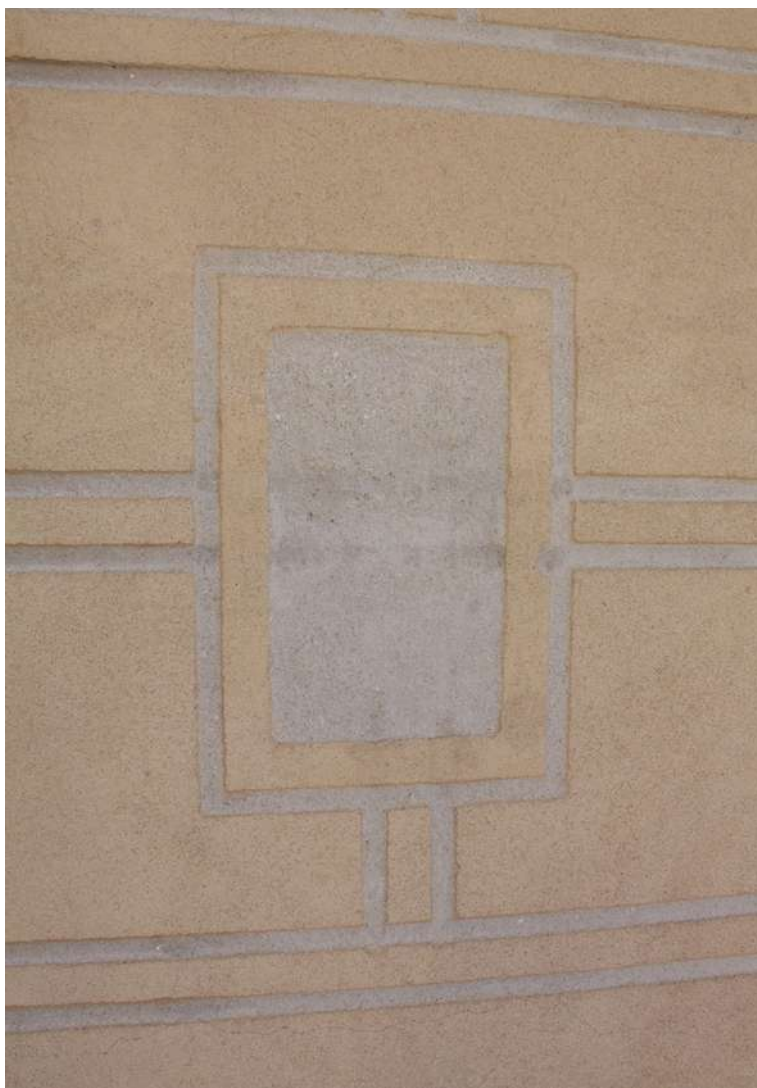
Obr. č. 72: detail patrné opravy tvaru sgrafita okolo okénka
