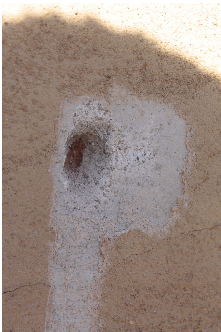
Obr. č. 21: stratigrafická sonda V7 v tympanonu nad vstupem
