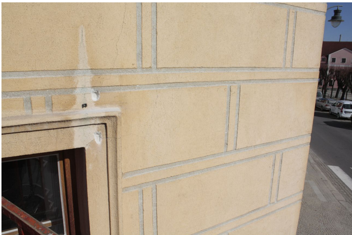
Obr. č. 56: stratigrafická sonda VJ4 nad oknem v přízemí
