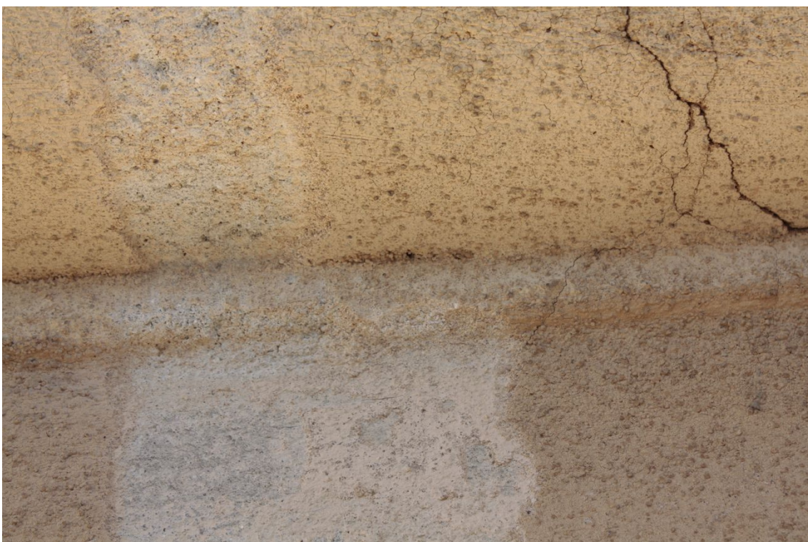
Obr. č. 20: detail stratigrafické sondy V5 na korunní římse
