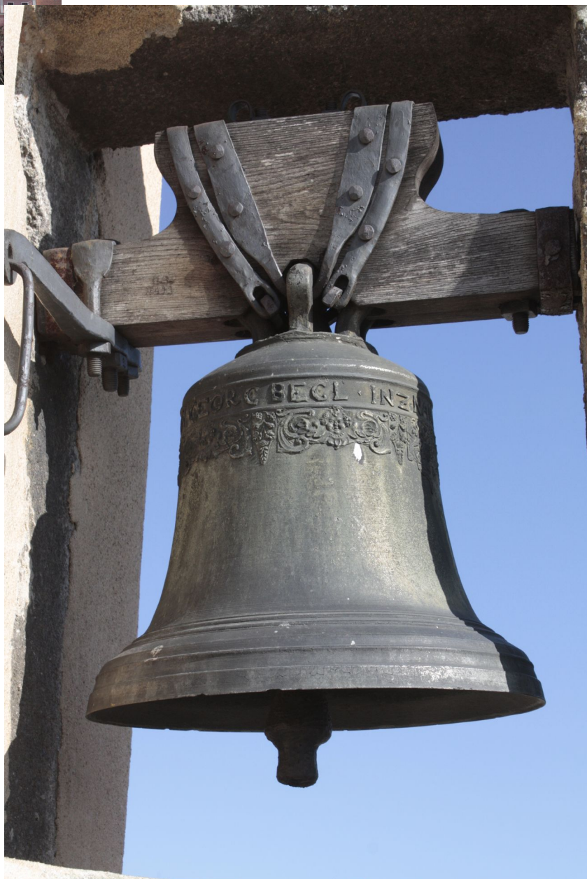
Obr. č. 47: detail zvonu včetně zavěšení
