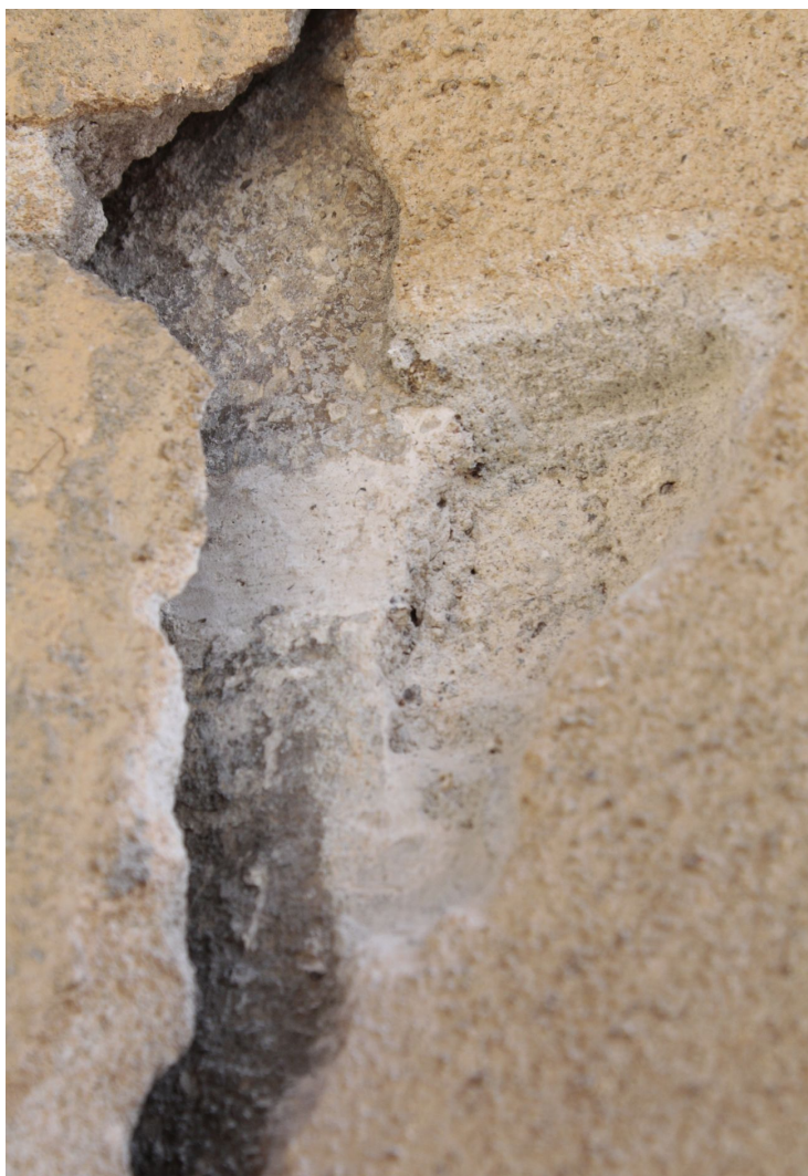
Obr. č. 70: detail stratigrafické sondy číslo VZ2 v místě, kde se dochovaly historické vrstvy omítek s nátěry
