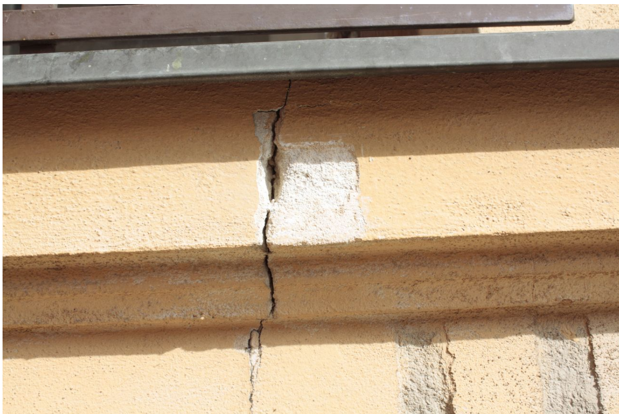
Obr. č. 90: stratigrafická sonda J6 na parapet okna v patře uprostřed jihozápadní fasády
