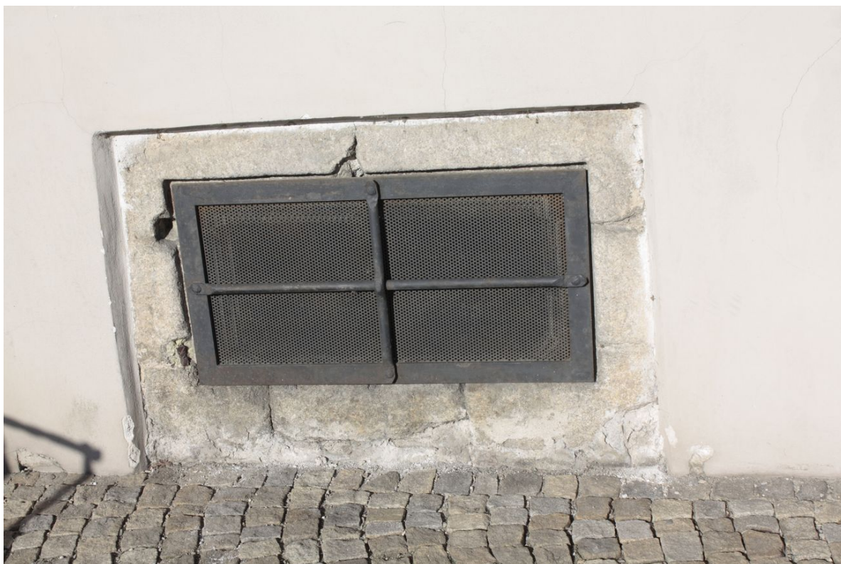
Obr. č. 11: detail kamenného ostění okénka do sklepa na levé straně fasády
