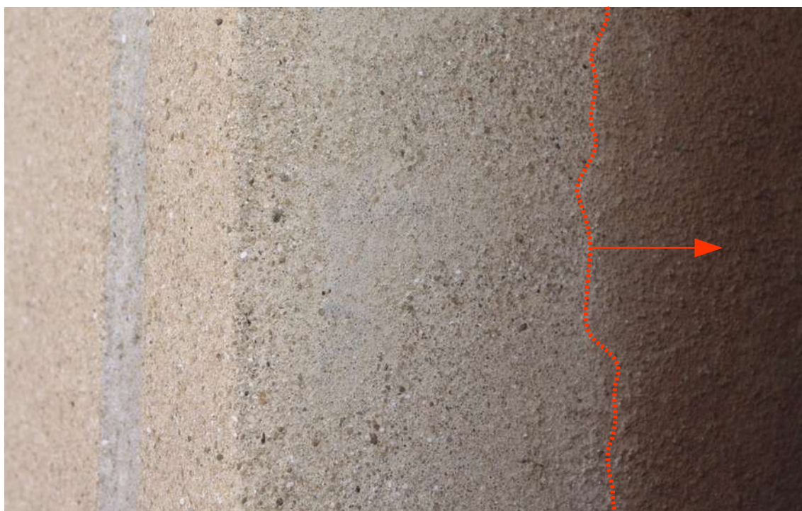
Obr. č. 64: detail okenní špalety, kde se v dešťovém stínu dochovala původní vrstva nátěru
