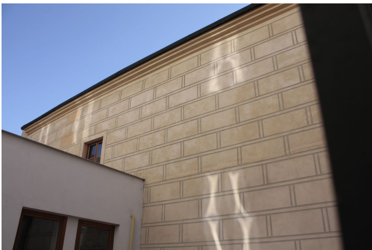
Obr. č. 93: pohled na pravou část severozápadní fasády Staré radnice
