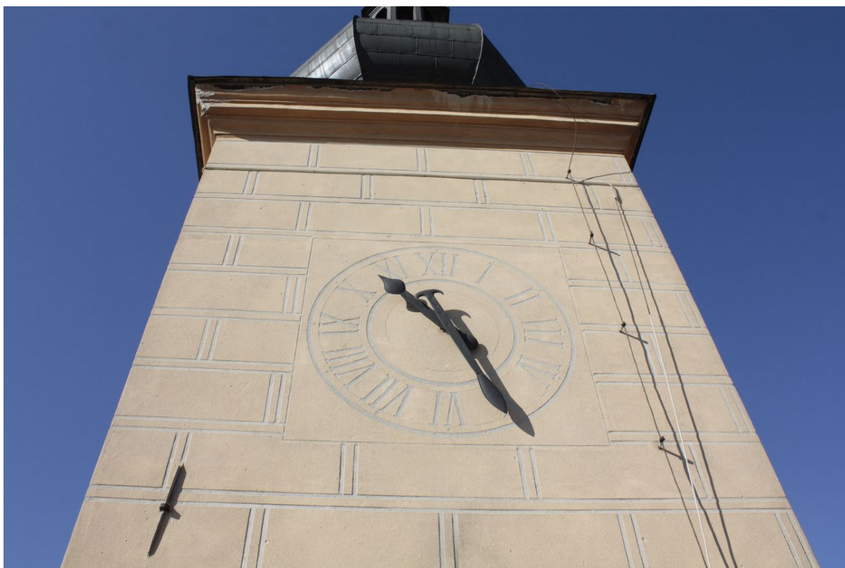
Obr. č. 25: pohled na východní fasádu radniční věže
