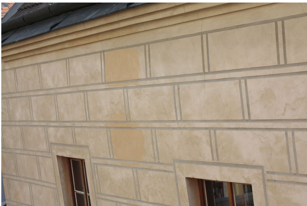
Obr. č. 95: detail levé části severozápadní fasády s opravnými přetěry omítek se sgrafitem
