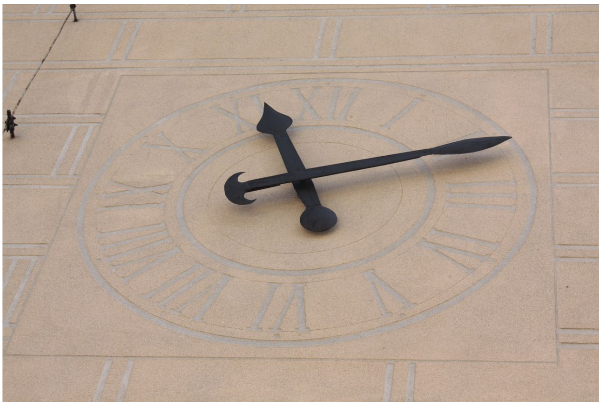
Obr. č. 60: detail hodinového ciferníku na západní straně věže
