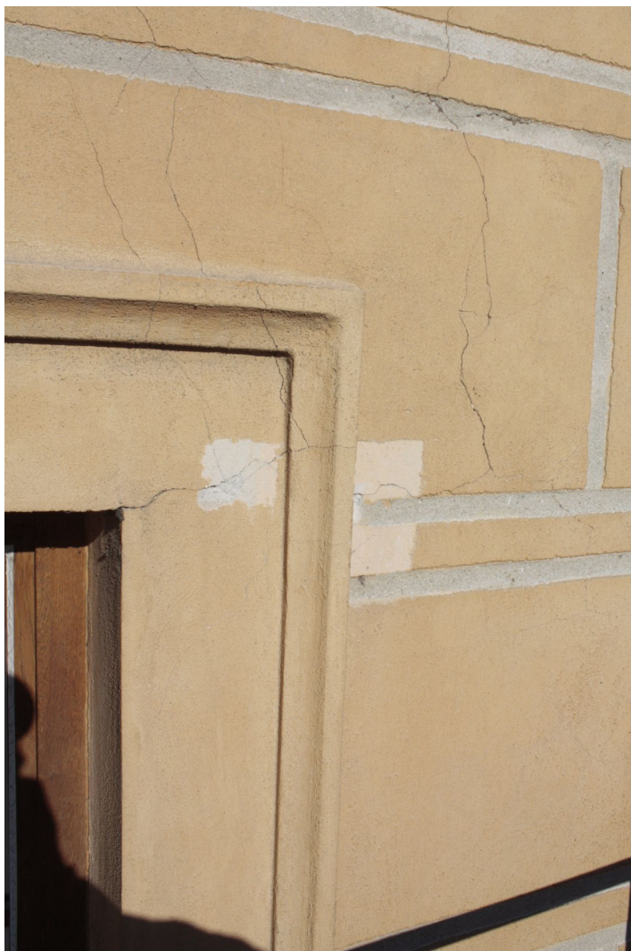
Obr. č. 16: detail stratigrafické sondy V2 na šambráně okna v patře
