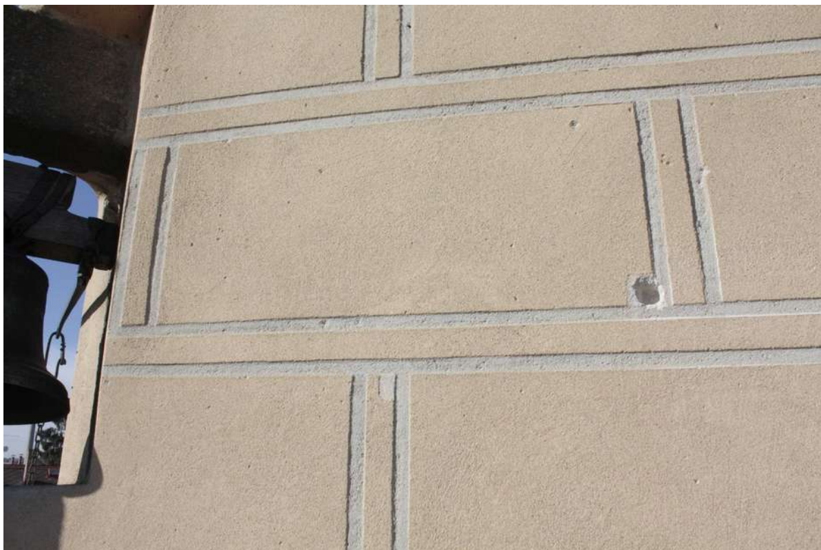
Obr. č. 32: stratigrafická sonda VV1 na východní fasádě věže
