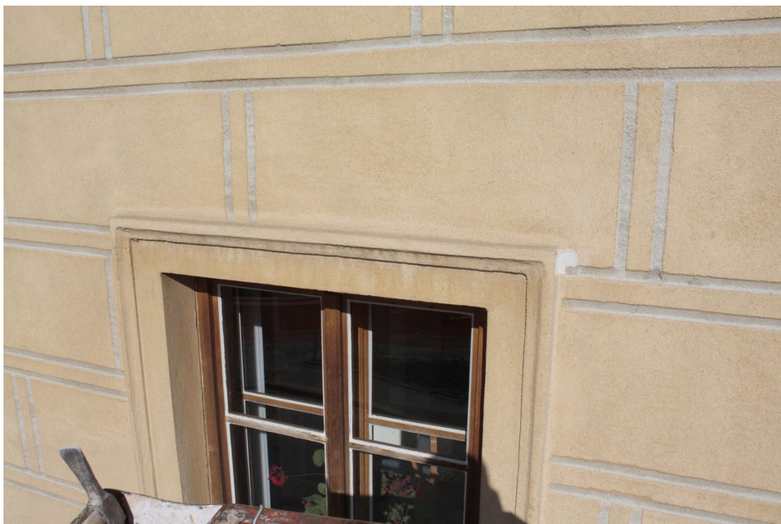
Obr. č. 54: stratigrafická sonda VJ3 u okna v patře
