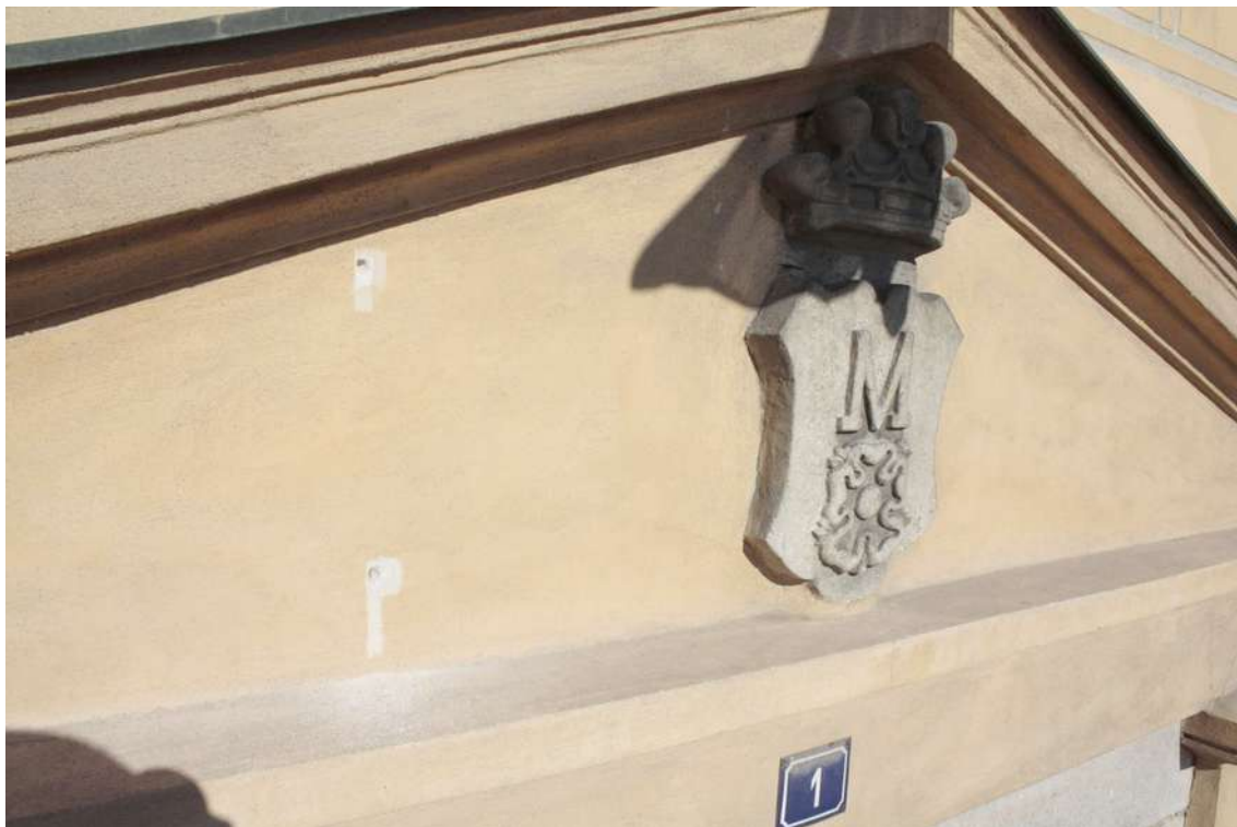
Obr. č. 21: stratigrafická sonda V7 v tympanonu nad vstupem
