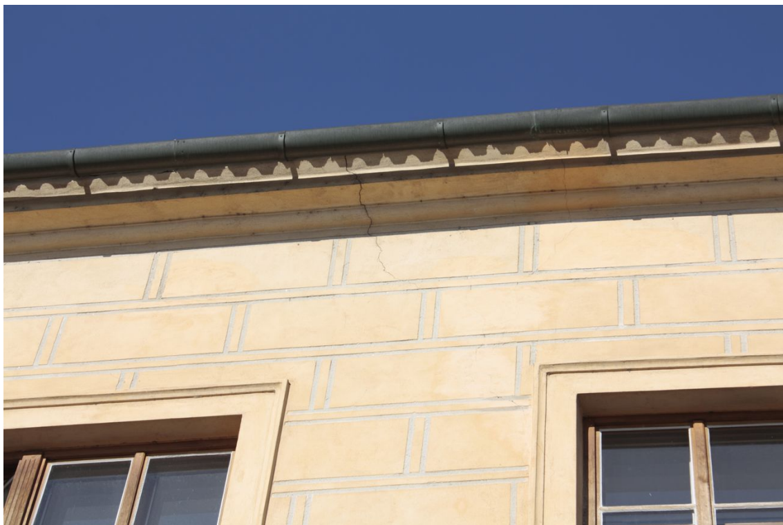
Obr. č. 5: detail poškození fasády mezi okny v patře fasády
