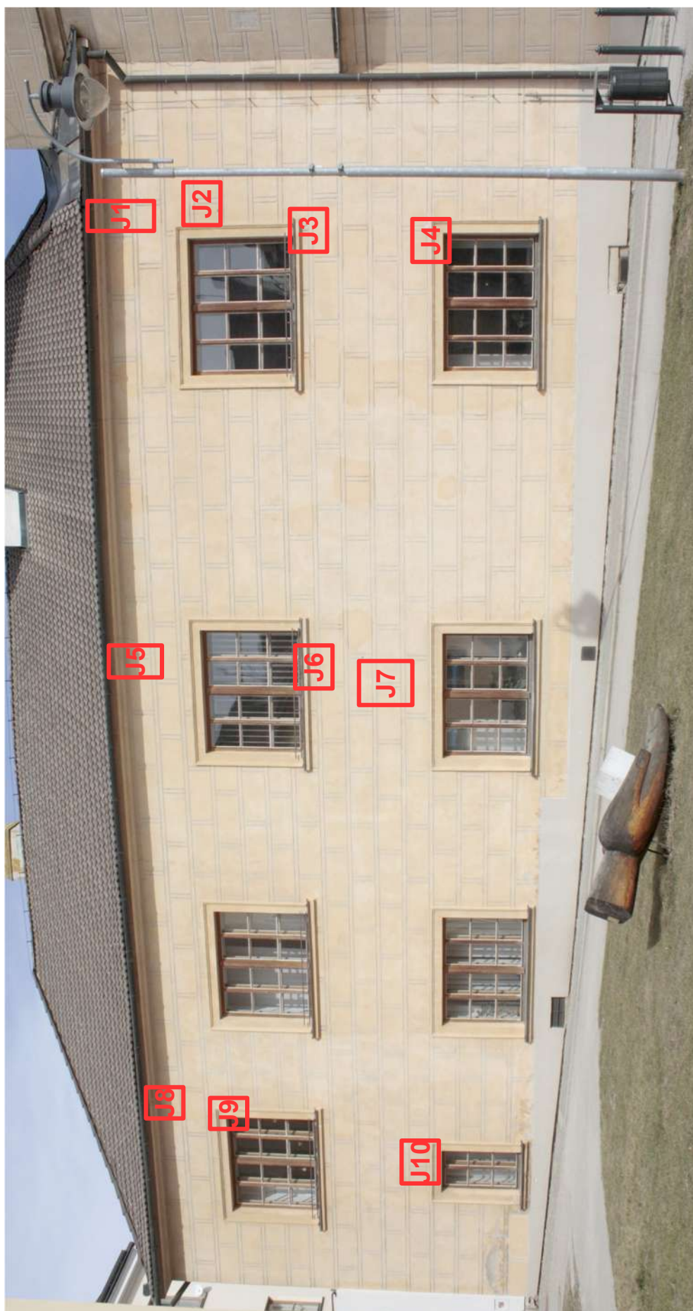
Stratigrafické sondy zhotovené na jihozápadní fasádě.
