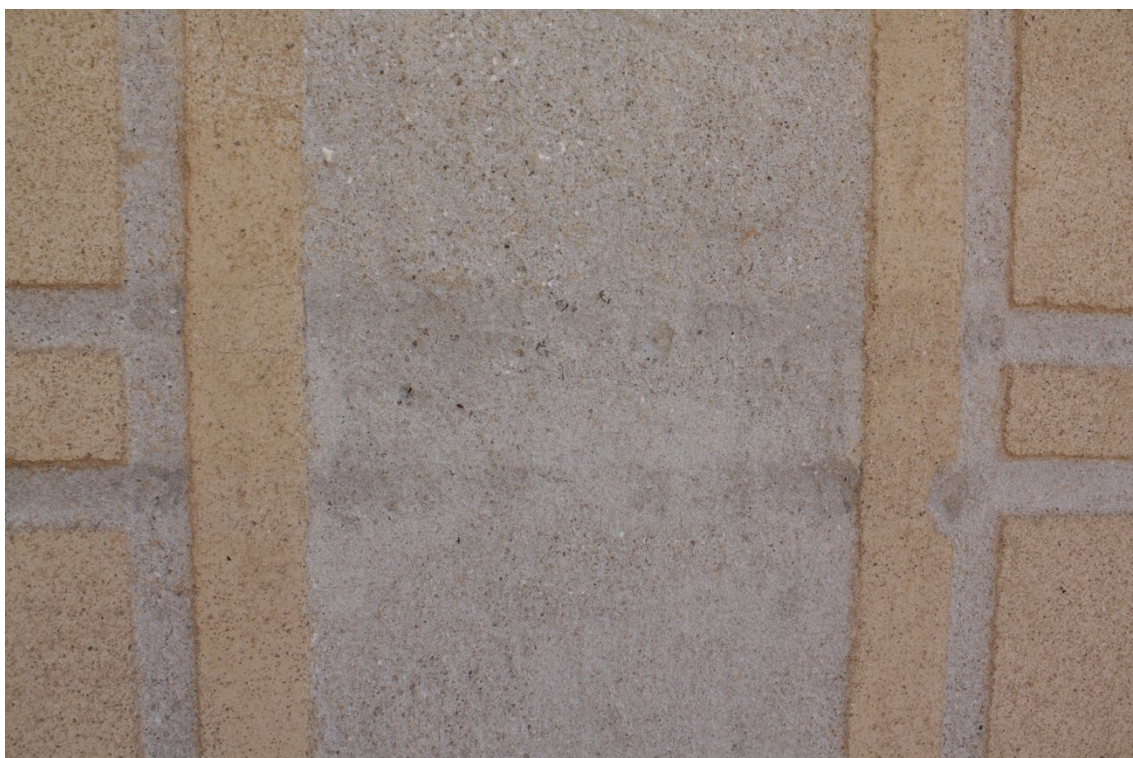
Obr. č. 72: detail patrné opravy tvaru sgrafita okolo okénka
