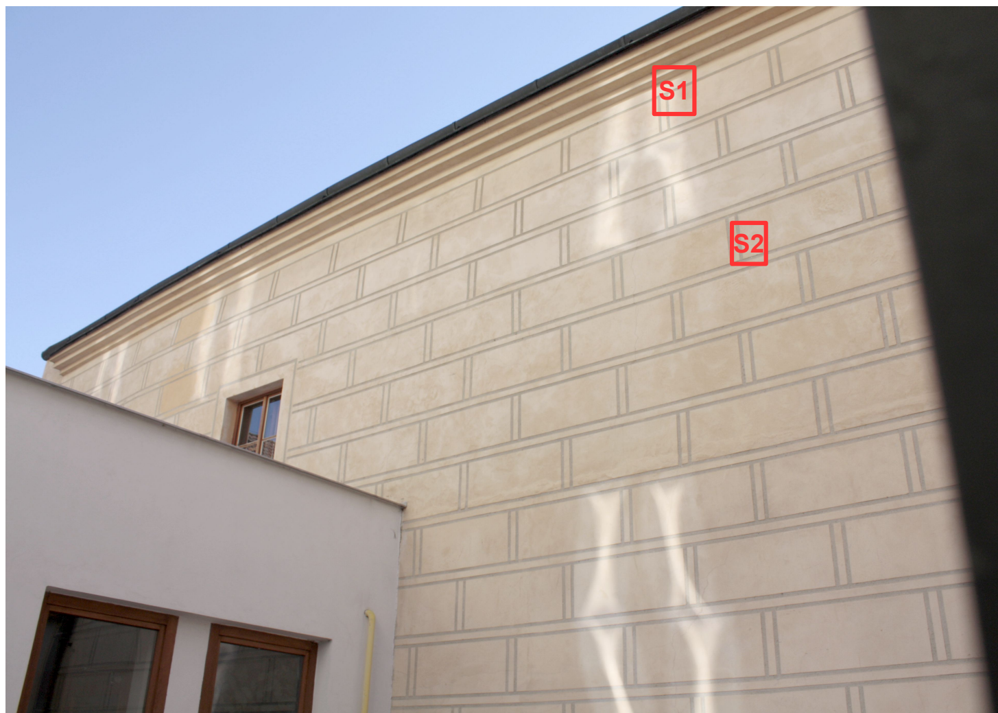
Stratigrafické sondy zhotovené na severozápadní fasádě.
