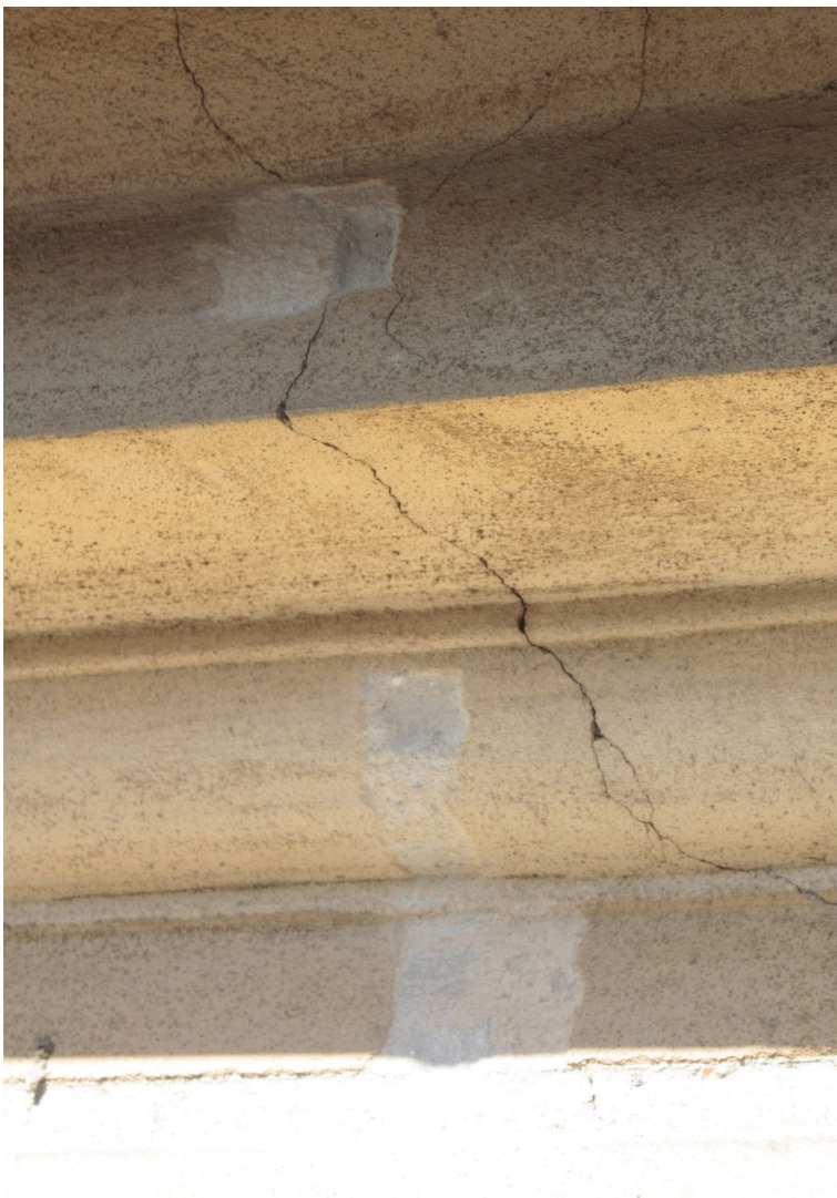
Obr. č. 20: detail stratigrafické sondy V5 na korunní římse
