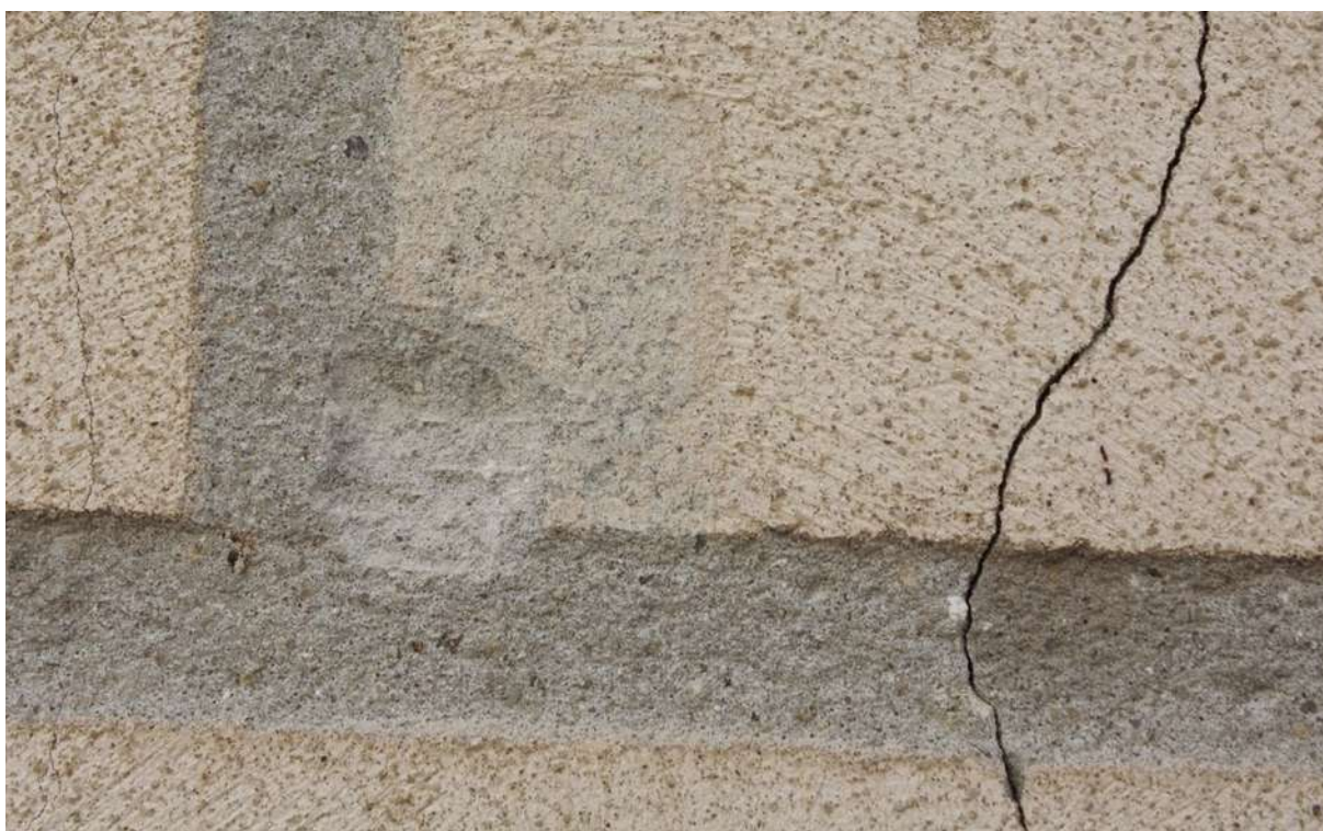
Obr. č. 97: detail stratigrafické sondy S2
