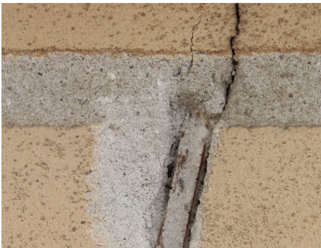
Obr. č. 89: detail stratigrafické sondy J5 v místě zaomítané železné kleštiny
