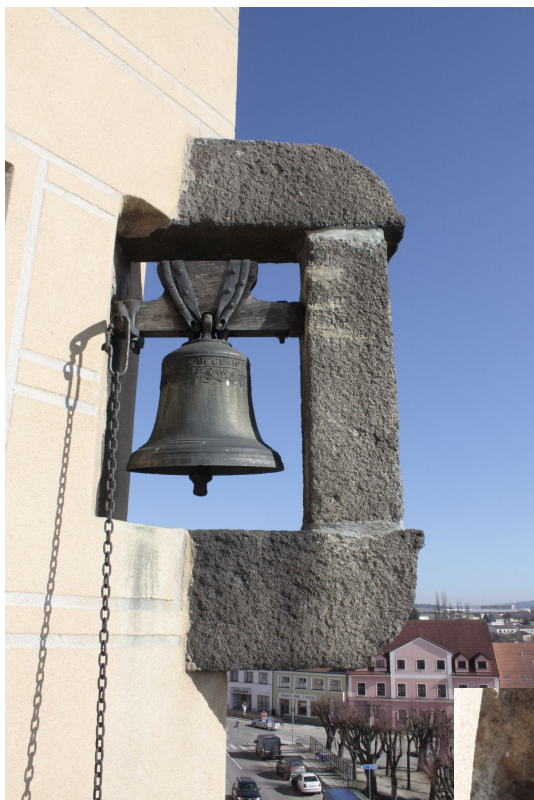
Obr. č. 46: detail kamenné konstrukce pro upevnění zvonu
