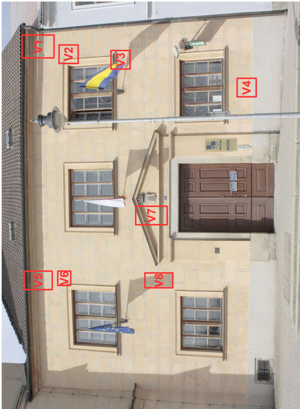
Stratigrafické sondy zhotovené na jihovýchodní fasádě.
