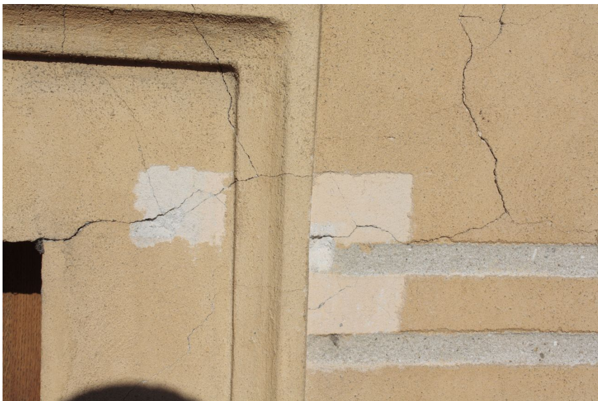
Obr. č. 16: detail stratigrafické sondy V2 na šambráně okna v patře
