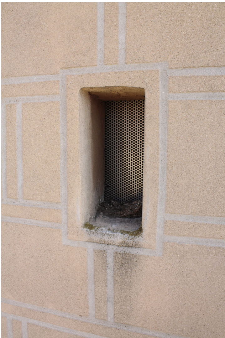
Obr. č. 64: detail okenní špalety, kde se v dešťovém stínu dochovala původní vrstva nátěru
