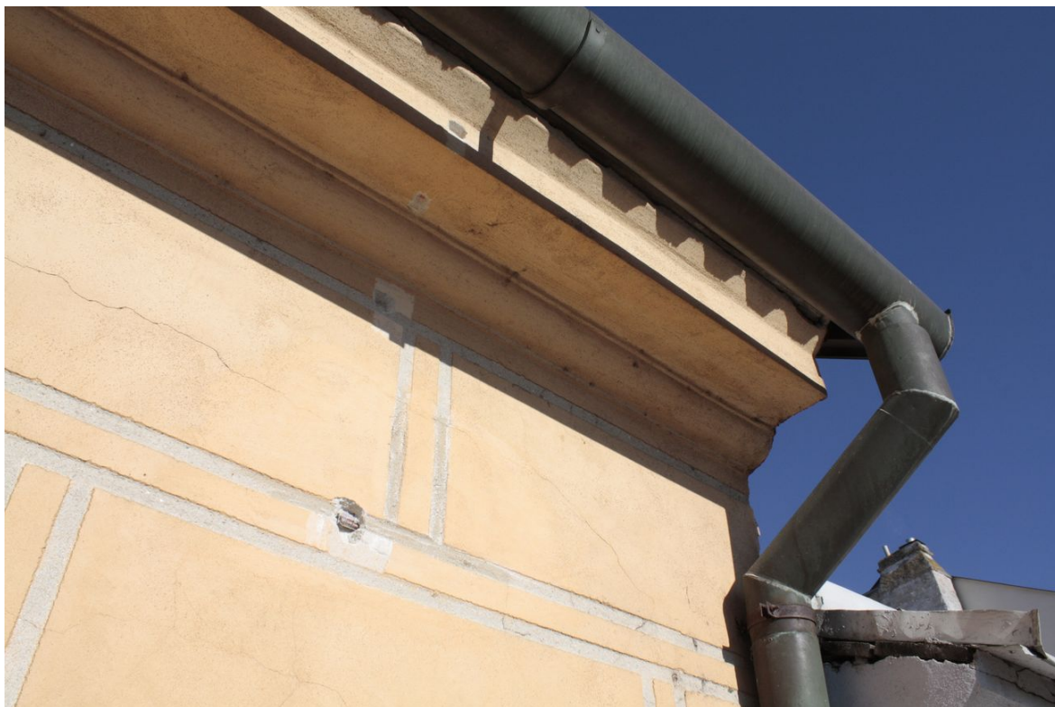
Obr. č. 13: stratigrafická sonda V1 v pravém horním rohu fasády
