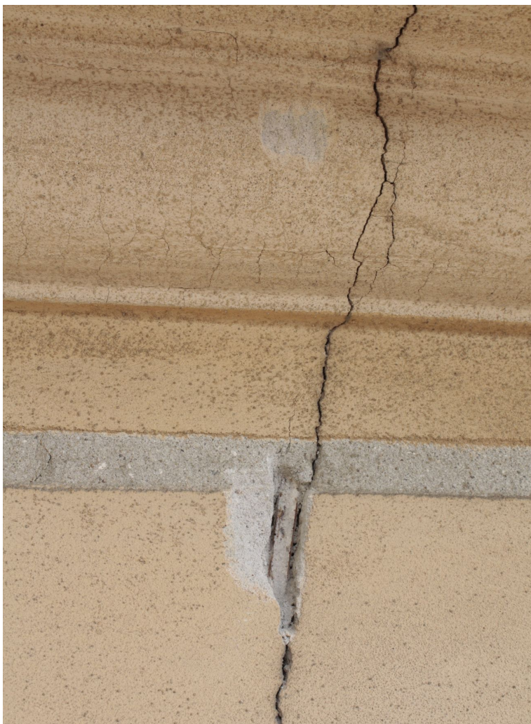
Obr. č. 89: detail stratigrafické sondy J5 v místě zaomítané železné kleštiny
