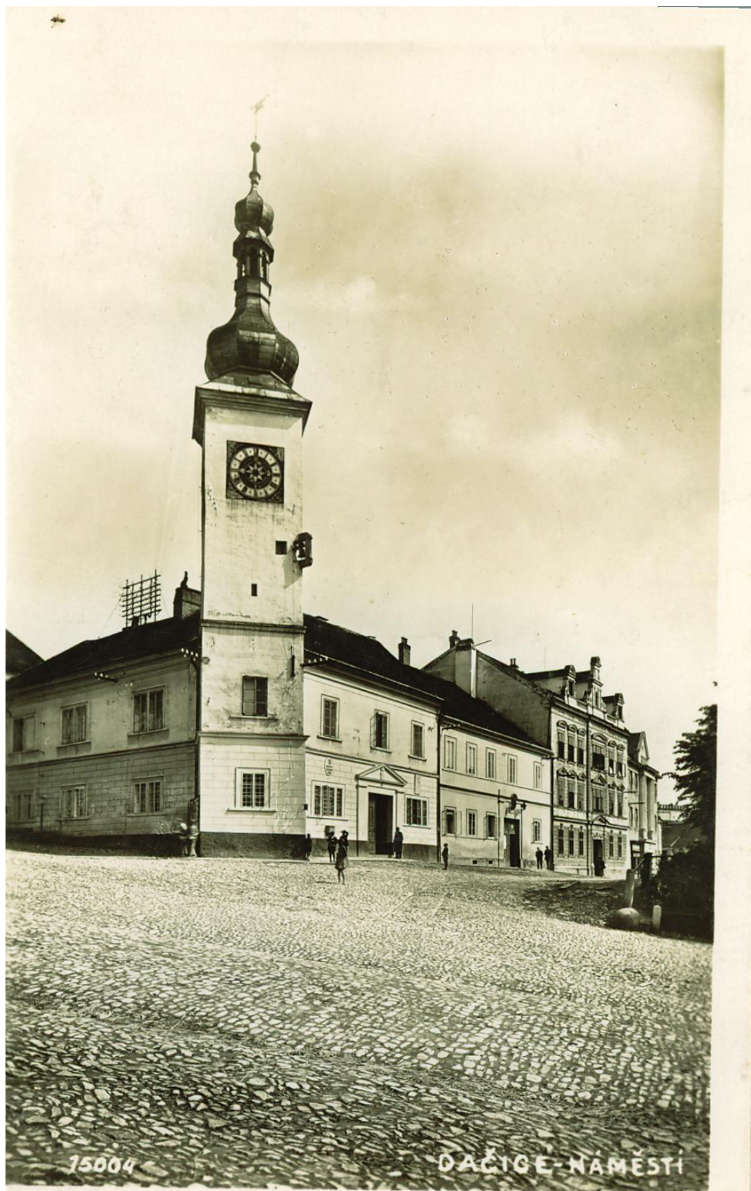
Obr. hist. č. 9: další z pohledů na budovu Staré radnice z první poloviny 20. století, v době kdy započala masivní elektrifikace domů, viz stožár na střeše
