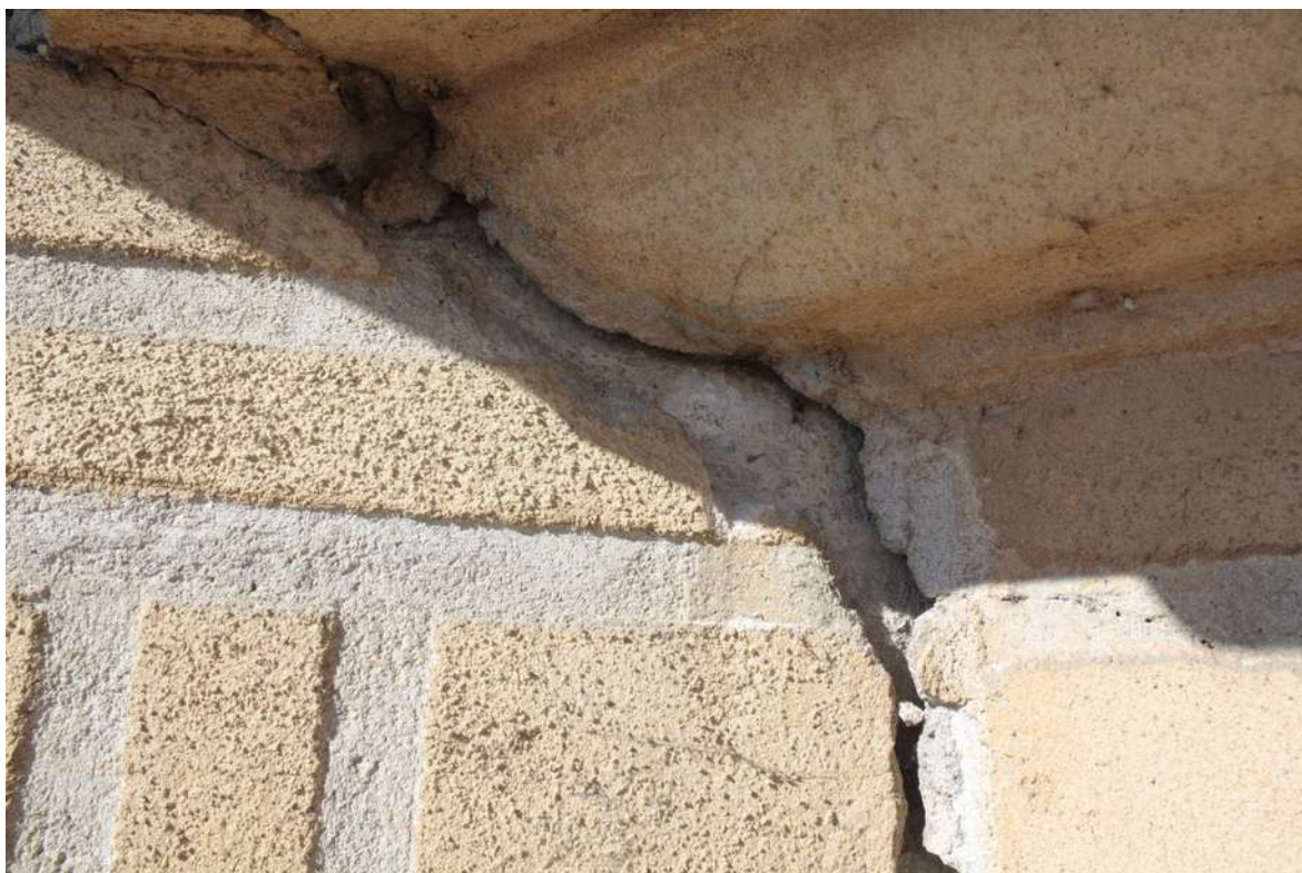
Obr. č. 36: stratigrafická sonda VV5 mezi východní fasádou věže a korunní římsou na jihovýchodní průčelní fasádě
