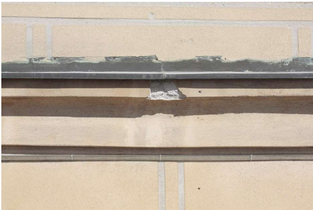
Obr. č. 52: stratigrafická sonda VJ2 na horní kordonové římse
