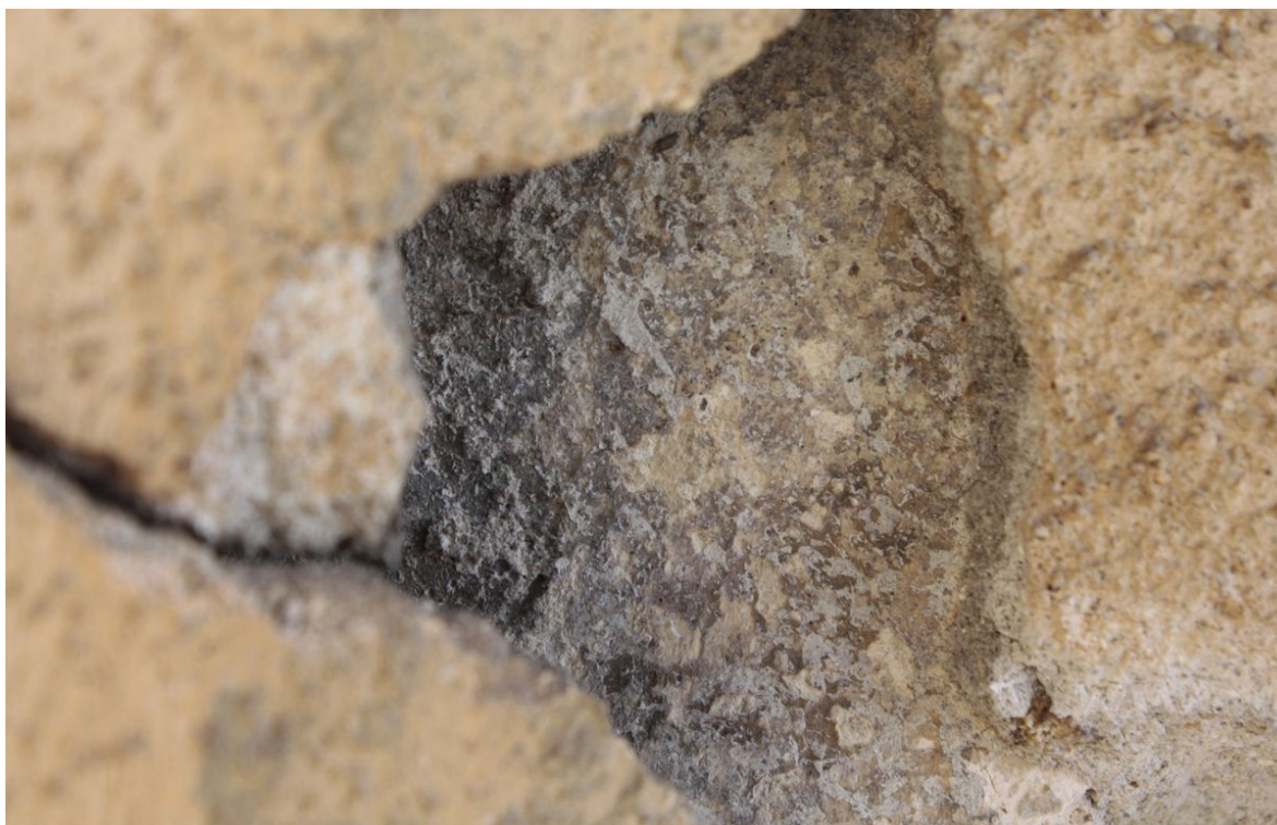
Obr. č. 70: detail stratigrafické sondy číslo VZ2 v místě, kde se dochovaly historické vrstvy omítek s nátěry
