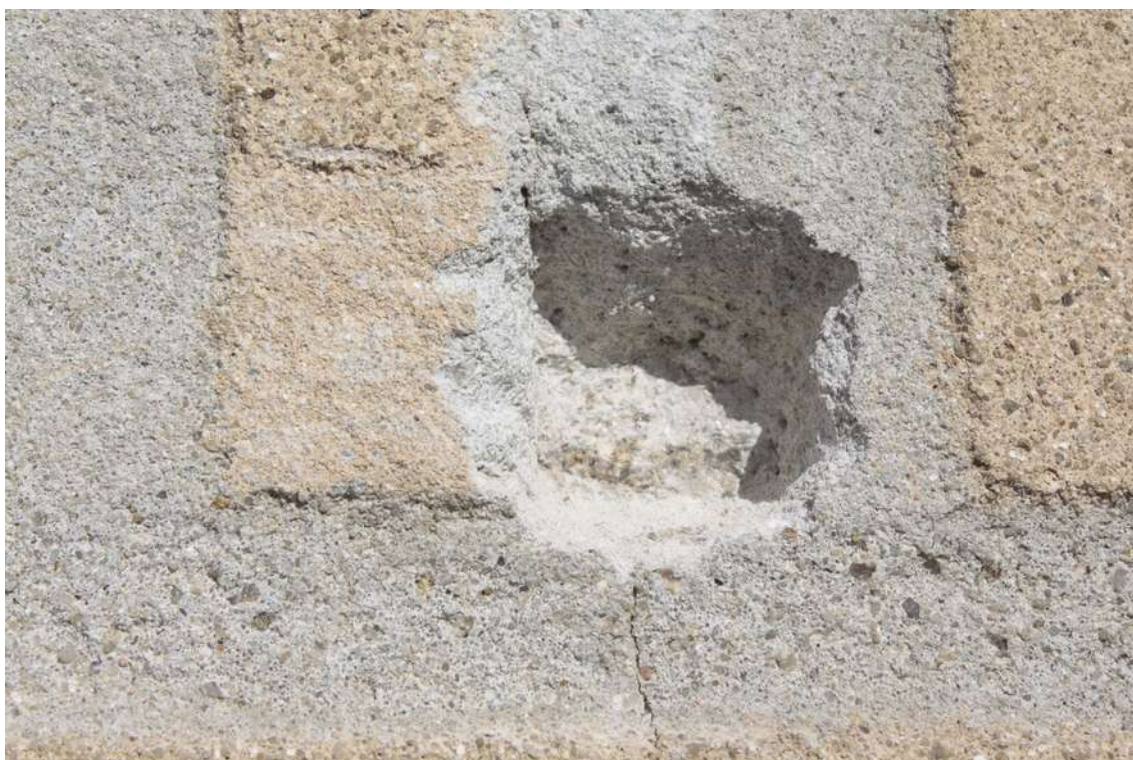
Obr. č. 51: detail stratigrafické sondy VJ1
