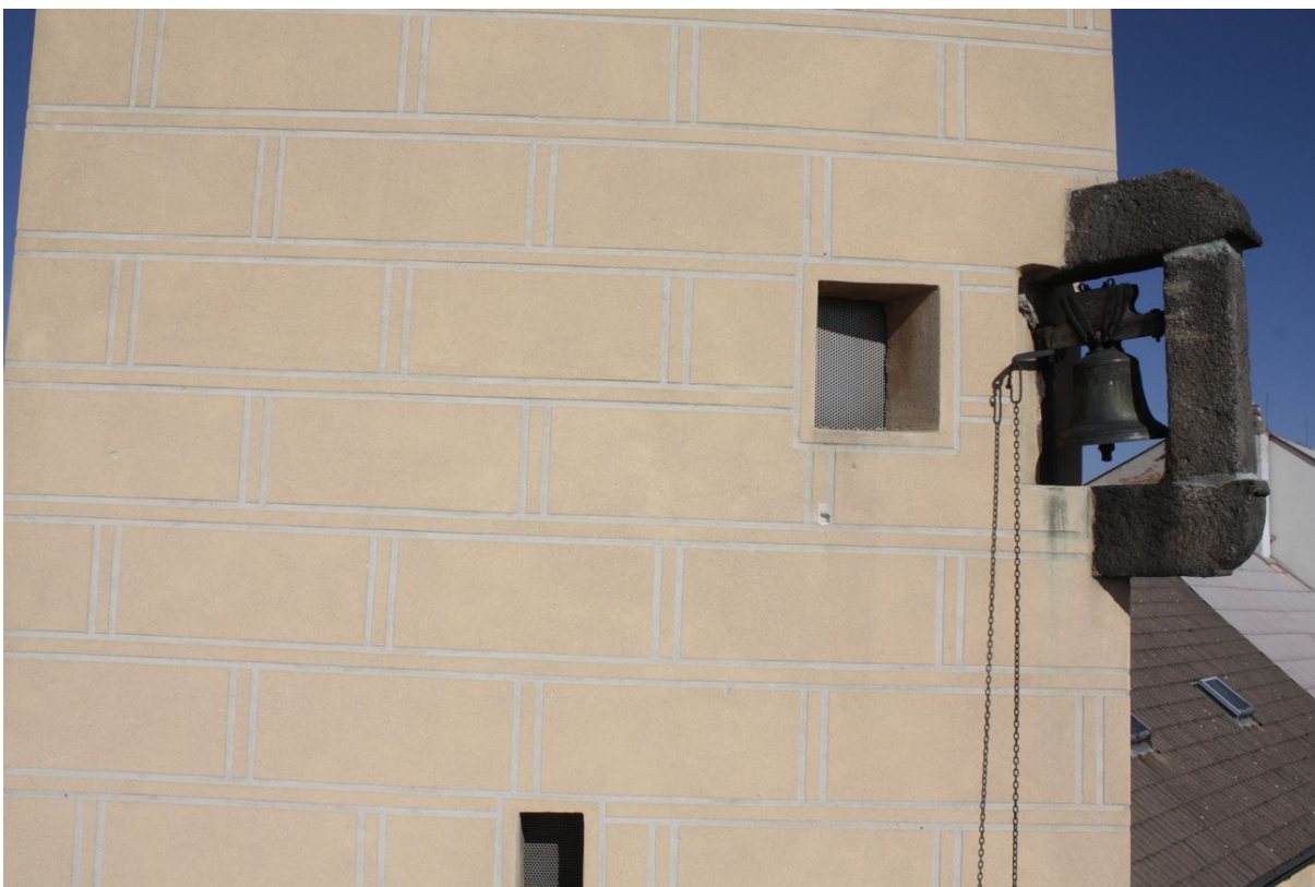
Obr. č. 45: celkový pohled na jižní fasádu věže se zvonem
