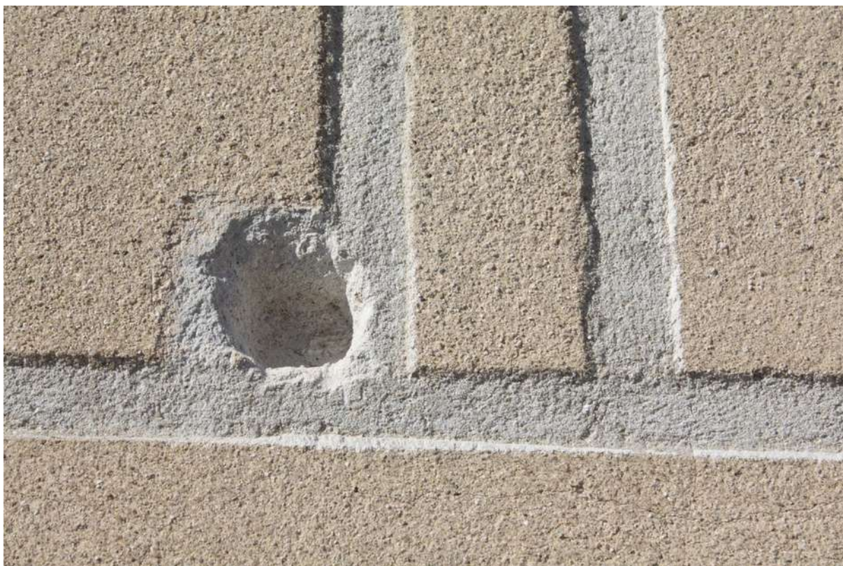
Obr. č. 33: detail stratigrafické sondy VV1
