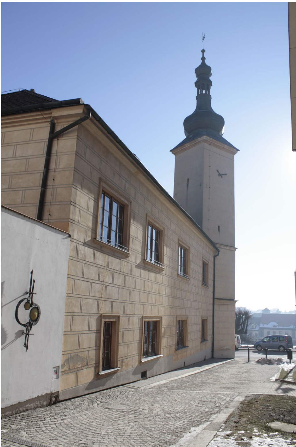
Obr. č. 79: celkový pohled na jihozápadní fasádu Staré radnice
