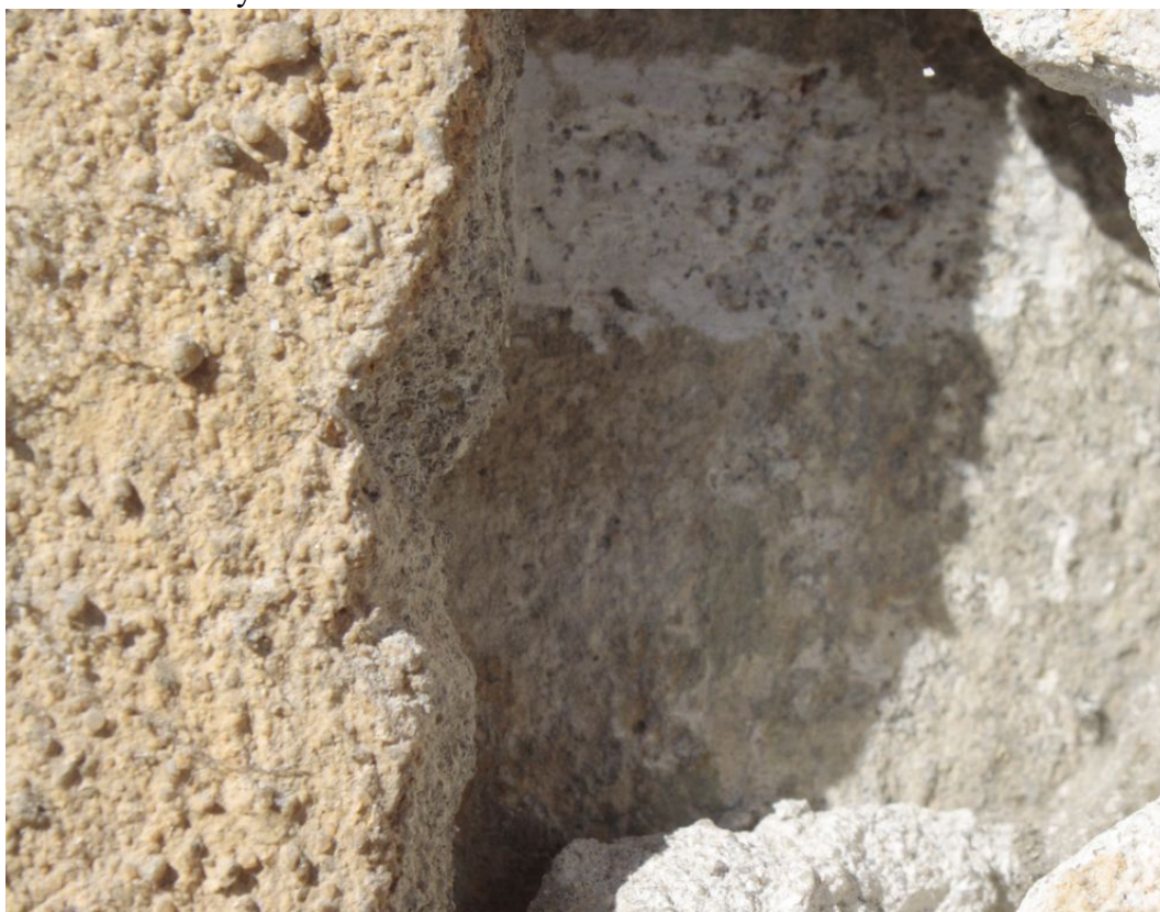
Obr. č. 39: detail stratigrafické sondy VV5 v místě, kde se dochovaly starší historické vrstvy omítek
