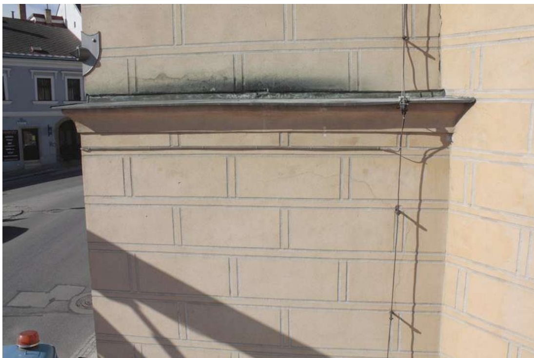
Obr. č. 40: stratigrafická sonda VV6 na spodní kordonové římsě
