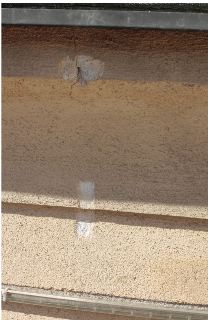
Obr. č. 40: stratigrafická sonda VV6 na spodní kordonové římsě
