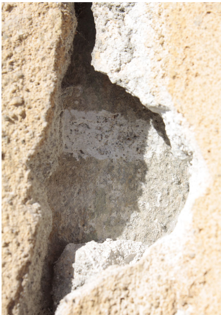
Obr. č. 39: detail stratigrafické sondy VV5 v místě, kde se dochovaly starší historické vrstvy omítek
