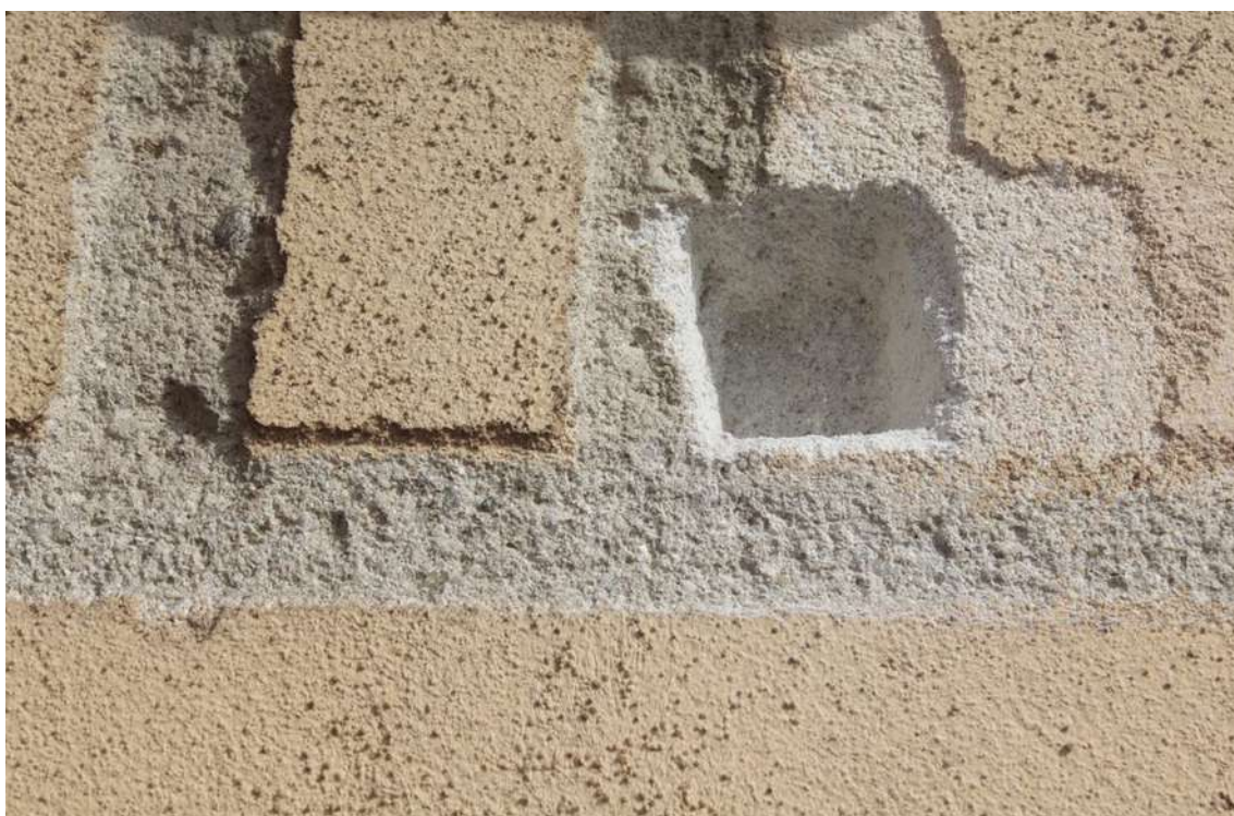
Obr. č. 87: detail stratigrafické sondy J3
