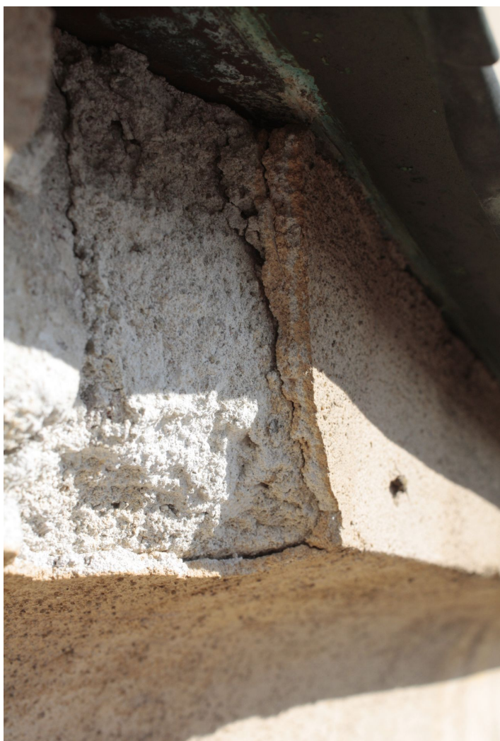
Obr. č. 52: stratigrafická sonda VJ2 na horní kordonové římse
