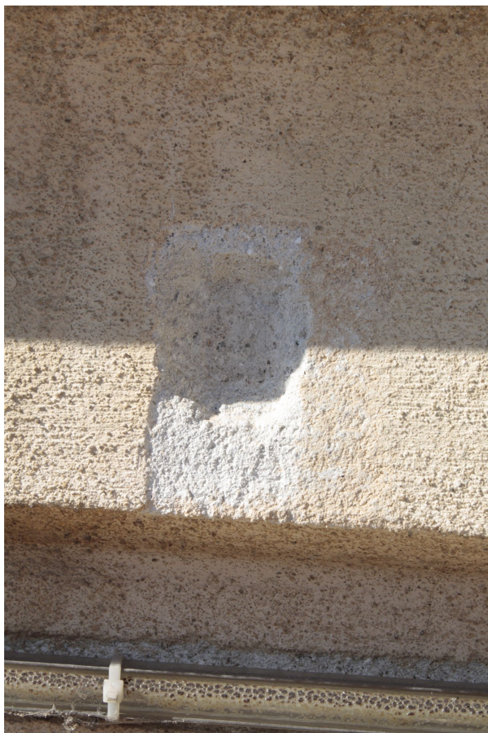
Obr. č. 34: stratigrafická sonda VV4 na horní kordonové římsce
