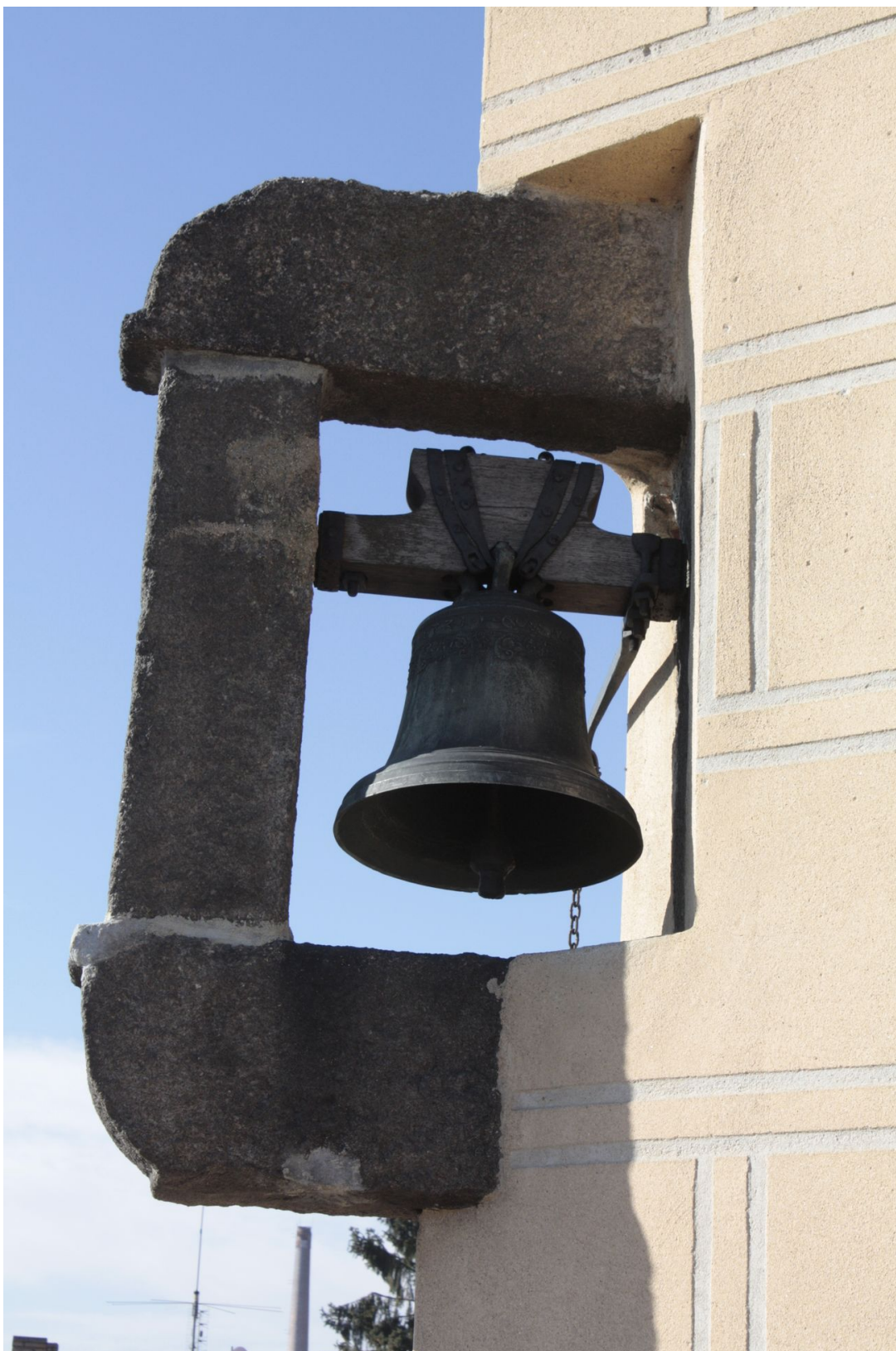
Obr. č. 29: detail kamenné žulové konstrukce pro zavěšení zvonu
