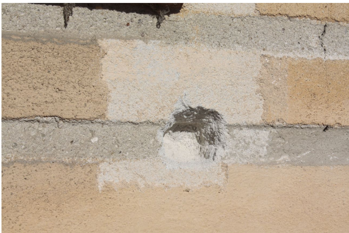
Obr. č. 18: detail stratigrafické sondy V3 pod oknem v patře
